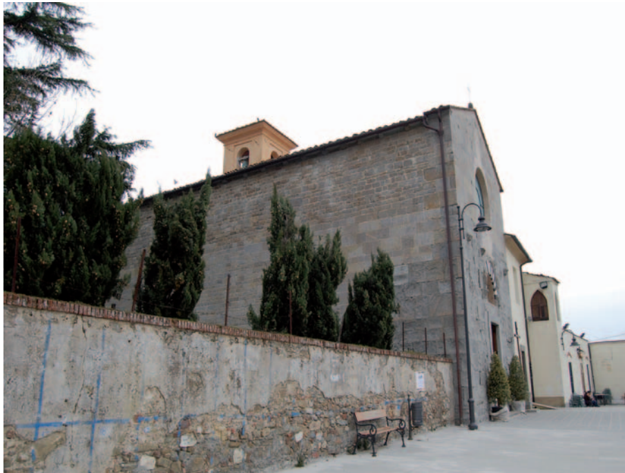
Fig. 1. Chiesa di S.M. Assunta già Monastero di S. Tommaso. Nella facciata, la parte inferiore in pietra serena risale all'VIII sec. e la parte superiore in pietra calcarea del XIII sec. Nell'immagine è ben visibile la trama lapidea del lato nord che mette in luce le diverse trasformazioni avvenute nel tempo.
